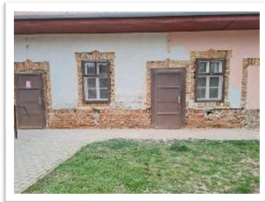
Raktár épület a felújítás előtt.
